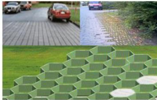
A parkolók vízáteresztő felületű kialakítása
